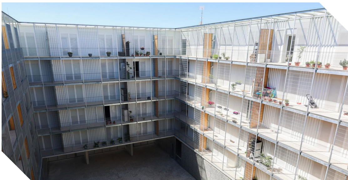
Le choix de parois diaphanes qui séparent les logements ou qui donnent vers l'extérieur permet que l'on peut voir et être vu.e.s, ce qui assure une plus grande sécurité
