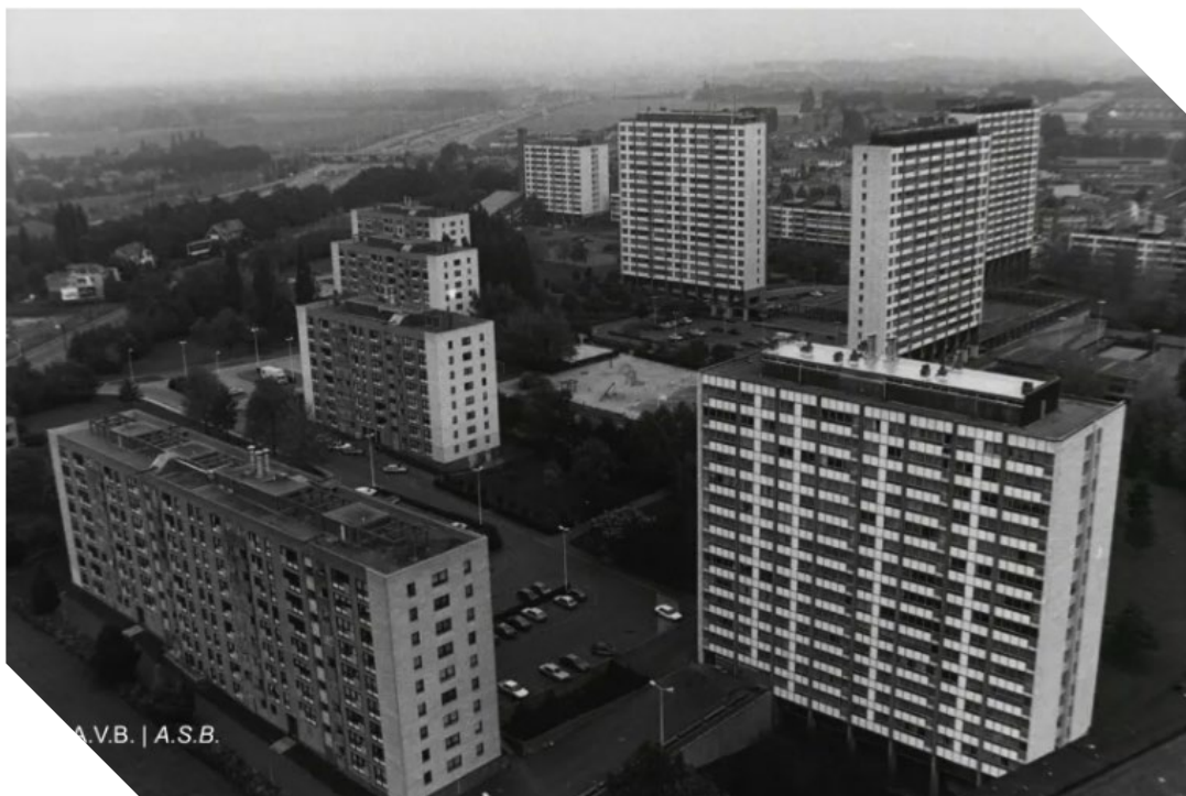
Vue d'ensemble des blocs de la Cité Modèle à Laeken. Atelier photographique de l'Urbanisme (c-23239). Archives de la ville de Bruxelles
