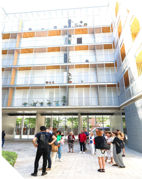
L'entrée principale du projet PISA CORNELLA se fait par la place, sous un grand portique commun favorisant les rencontres et les relations de voisinage.
